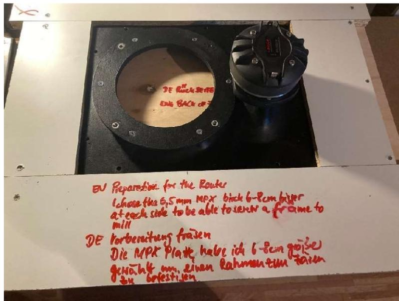
Danach entfernt man die Front Platte wieder, nimmt einen Bündigfräser und fräst das Loch für die Front Platte aus.
